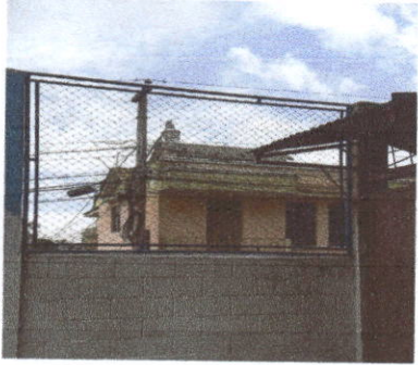
Foto1: Reparación de muro de contrucción de 2.00 por 2.00 metros cuadrados
