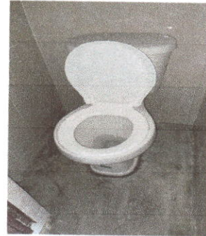
Foto 6: Sustitucion de ocho sanitarios con sus respectivos accesorios
