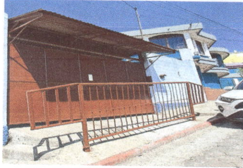
Foto 2: Limpieza, lijado, cepillado y pintura general del porton de la entrada principal de la escuela.
